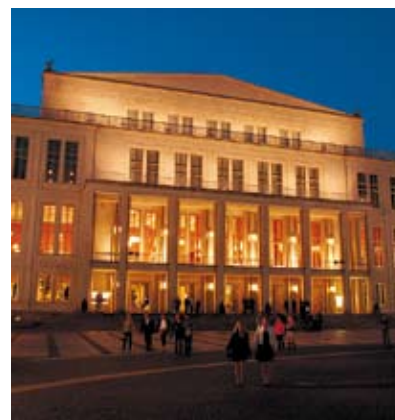
Das Opernhaus verfügt seit der Sanierung 2007 über 1 267 Sitzplätze.
